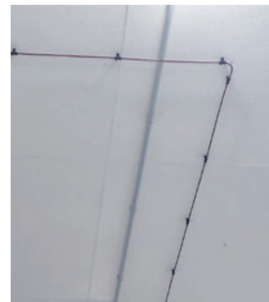
Vista do sistema de aspersão, instalado utilizando o sistema de abastecimento Geberit Mapress Aço Inoxidável.
